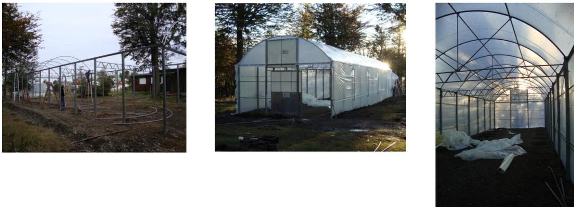
Figura N° 3: Instalación de la estructura de invernadero de hierro galvanizado de tipo semiparabólico de pared recta, adquirido a la empresa IRIE HNOS. S.R.L. Con dimensiones de 6 mts. Por 20 mts., 3 mts. de altura al lateral y 4,5 mts. a la cumbre.
