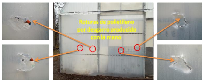
Imagen 17: Roturas de la cobertura de polietileno en la pared frontal.
