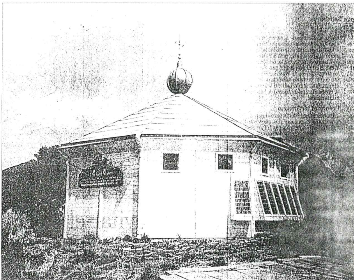
Así quedó el faro del fin del mundo, luego del trabajo de los carpinteros: nuevas ventanas y pintura exterior para preservarlo de las lluvias
