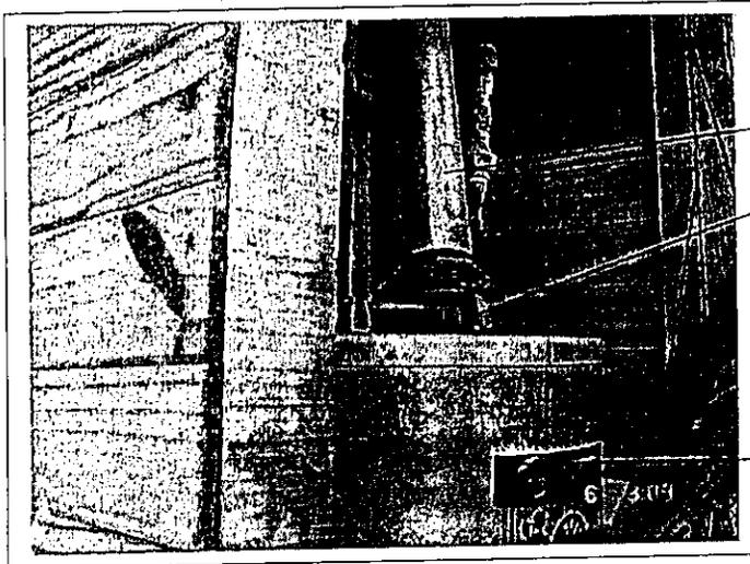
Gabinete de madera, precario para alojar el termotanque de Planta Baja. Se advierte desoldada la salida de humos y mala conexión del caño de salida de humos. De acuerdo a la información recibida, este termotanque es usado y es el que estaba antes en 1° piso
