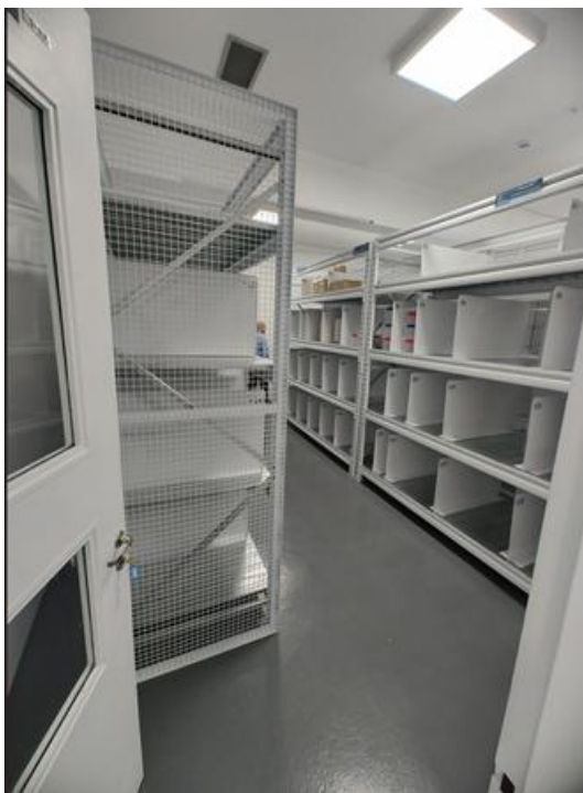
RACKS CON CERRAMIENTO
