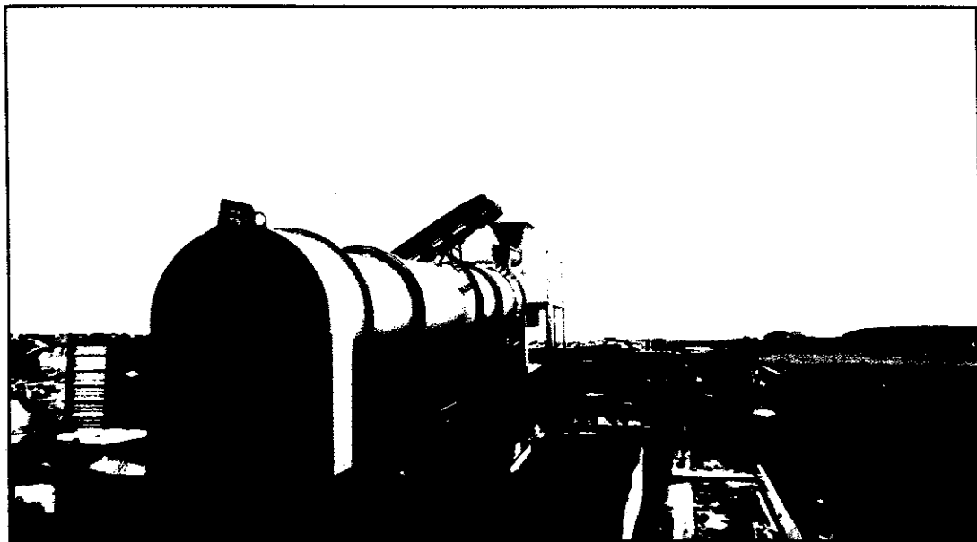
Horno rotativo a la espera de la instalación de la cámara secundaria
